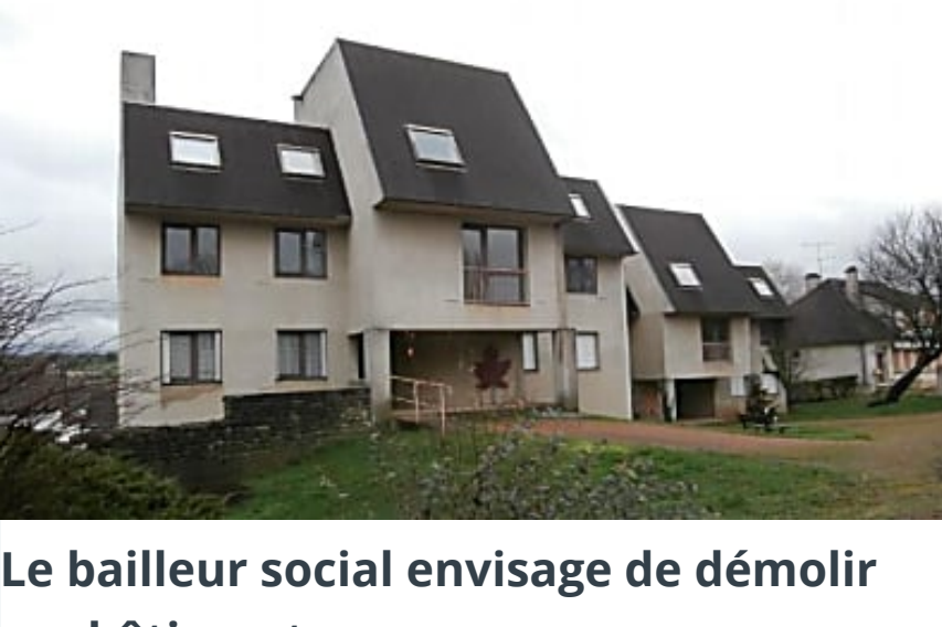
Le bailleur social envisage de démolir ces bâtiments
